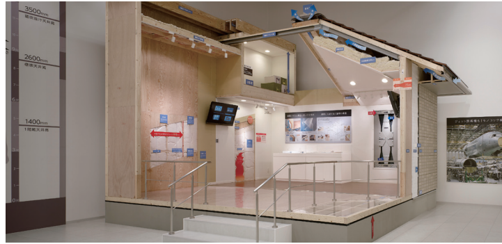
一体構造を形成するミサワホームの構造躯体
